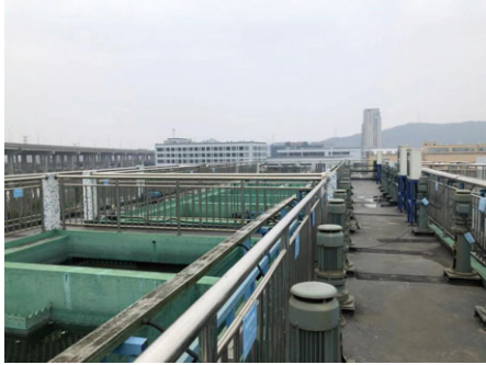
圖中是廠區的污水處理設施
