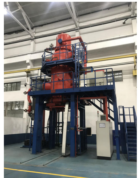
圖中是位於寧波其中一個廠區熱處理車間的真空淬火爐。
